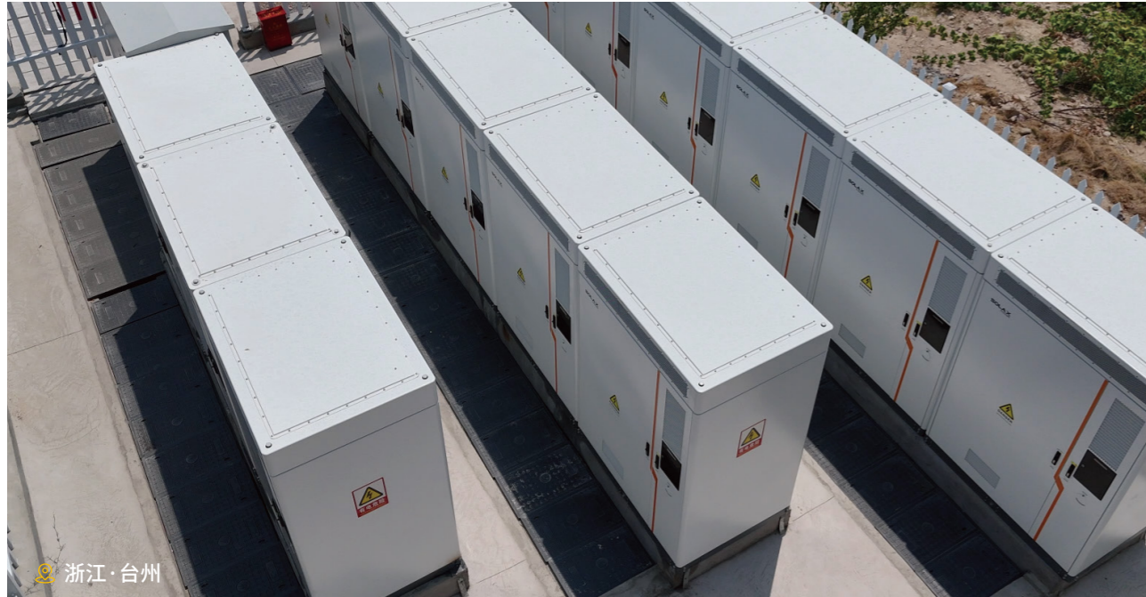
工商业储能 | 项目容量: 3MWh 应用产品: TRENE-P100B215一体化工商业储能机柜
