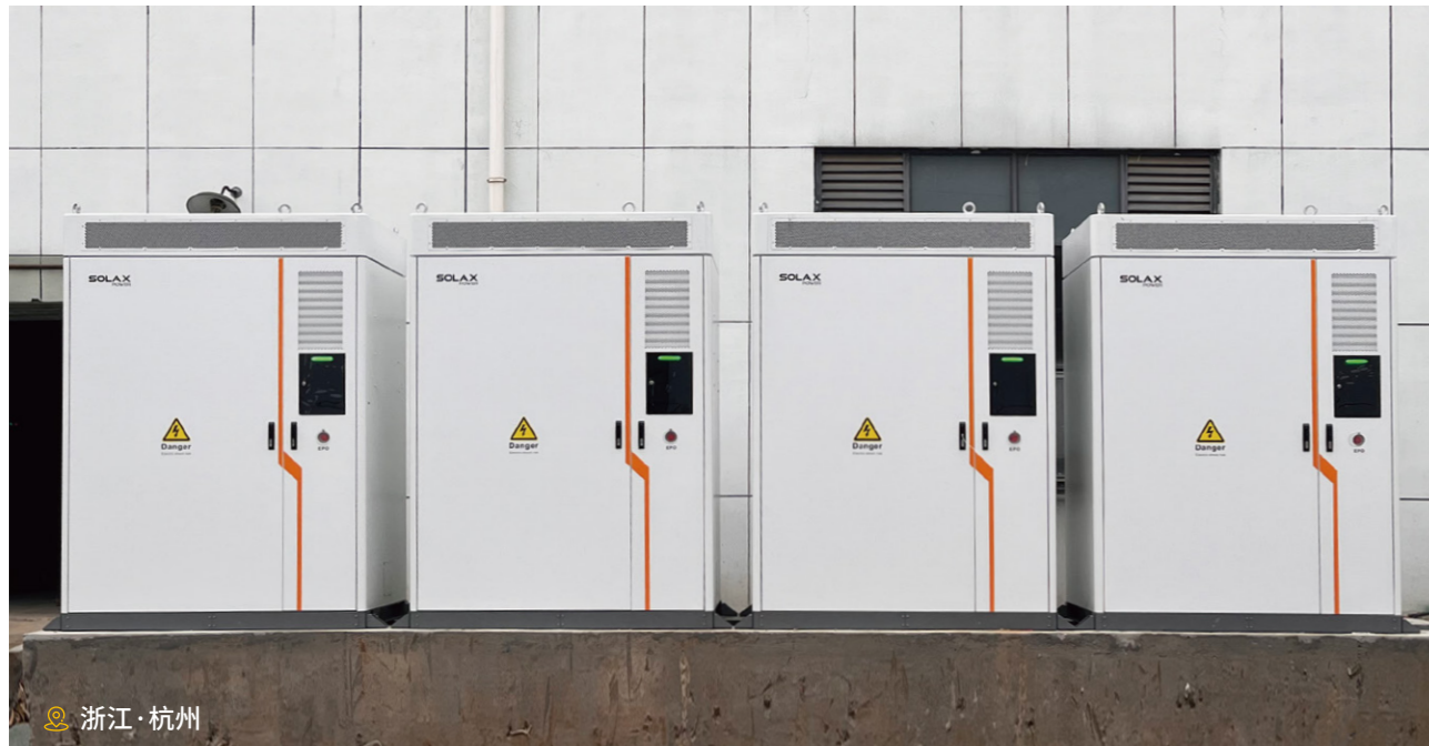
工业园区储能 | 项目容量: 2MWh 应用产品: TRENE-P100B215一体化工商业储能机柜
